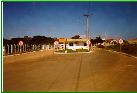
Figura 3 – Vista da entrada de um aterro sanitário
